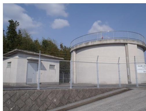
ハイテク地域配水池
