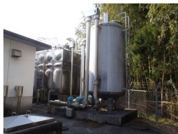
安岐地域北部浄水地
